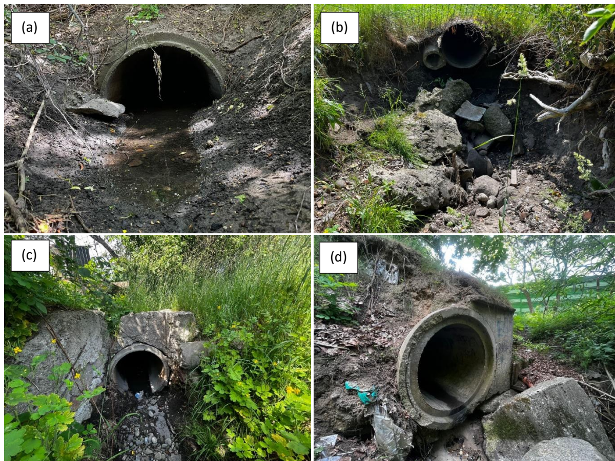
Rysunek 3. Przepusty na potoku Demptowskim: (a) Kd800 pod dawnym Domem Dziecka; (b) kd500 posesja Demptowska 10 (c) kd800 wlot w kierunku obwodnicy trójmiasta (d) kd 1200 wylot pod ul. Jaksótczą
