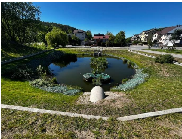
Rysunek 13 Zbiornik na dopływie do Potoku Demptowskiego, widok w dół ciek
