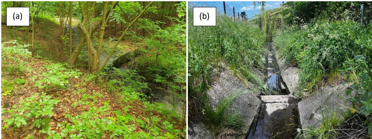
Rysunek 2. Próg z palisady drewnianej w górnym biegu potoku (a) oraz betonowy na dolnym biegu potoku (b)
