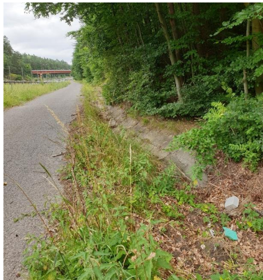
Rysunek 10. Rów odprowadzający wodę z górnej części zlewni Potoku Demptowskiego (A4 i A5); widoczne zakończenie rowu kierujące wodę do zlewni leśnej A2; w tyle widoczny wiadukt trasy Kwiatkowskiego nad obwodnicą trójmiejską.
