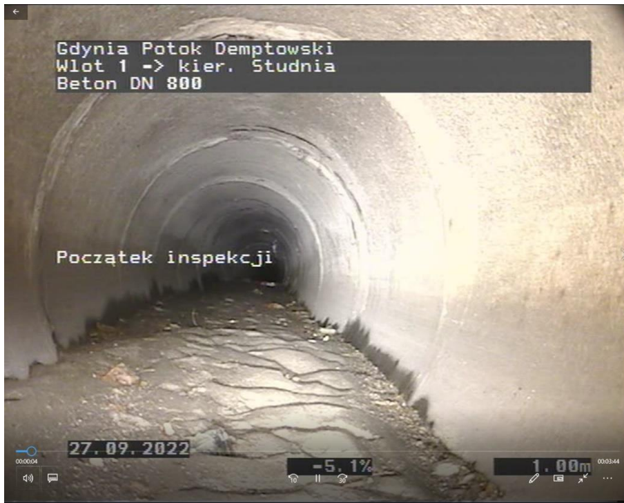
Rysunek 32. Wejście do rurociągu \varnothing 800 w rejonie ul. Chabrowej
