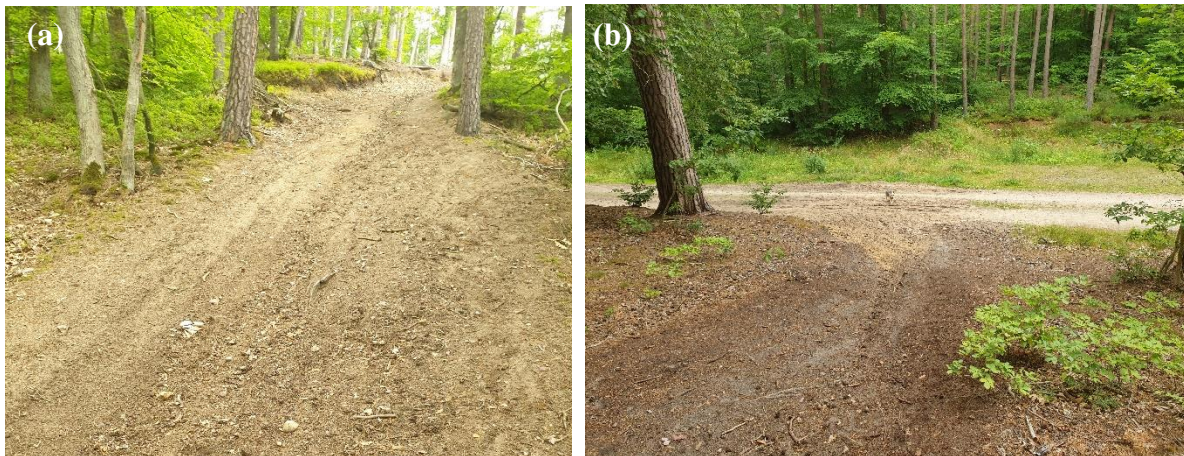
Rysunek 8 dzikie zejście z widoczną erozją gruntu (a); odsypisko gruntu na drodze (b)
